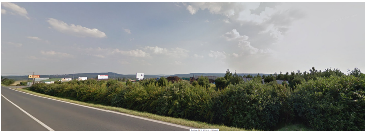
Obrázek 9: Pohled na kompostárnu (Z1/15) od silnice II/603
